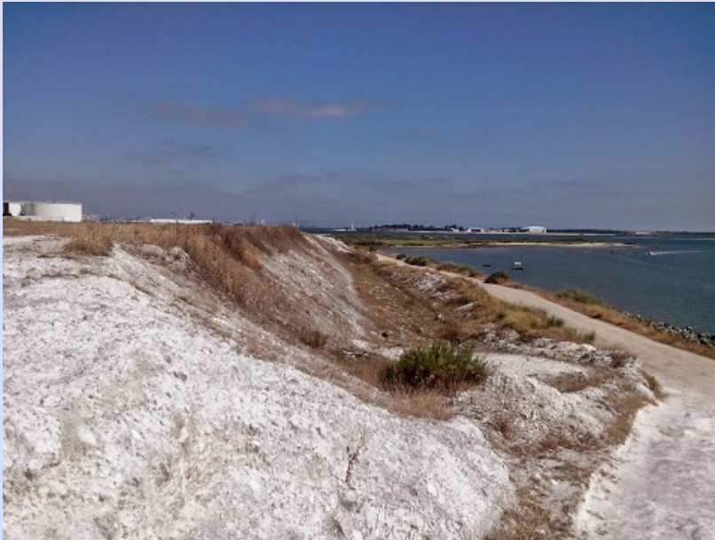
Talude do aterro do Lavradio na frente estuarina
